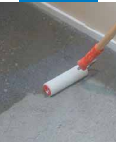
Auftragen von Primer G mit der Rolle
